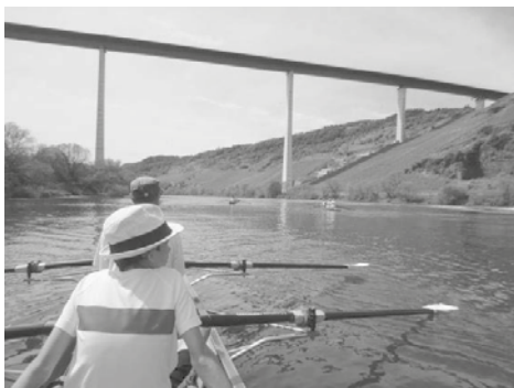
Der neue Hochmoselübergang
